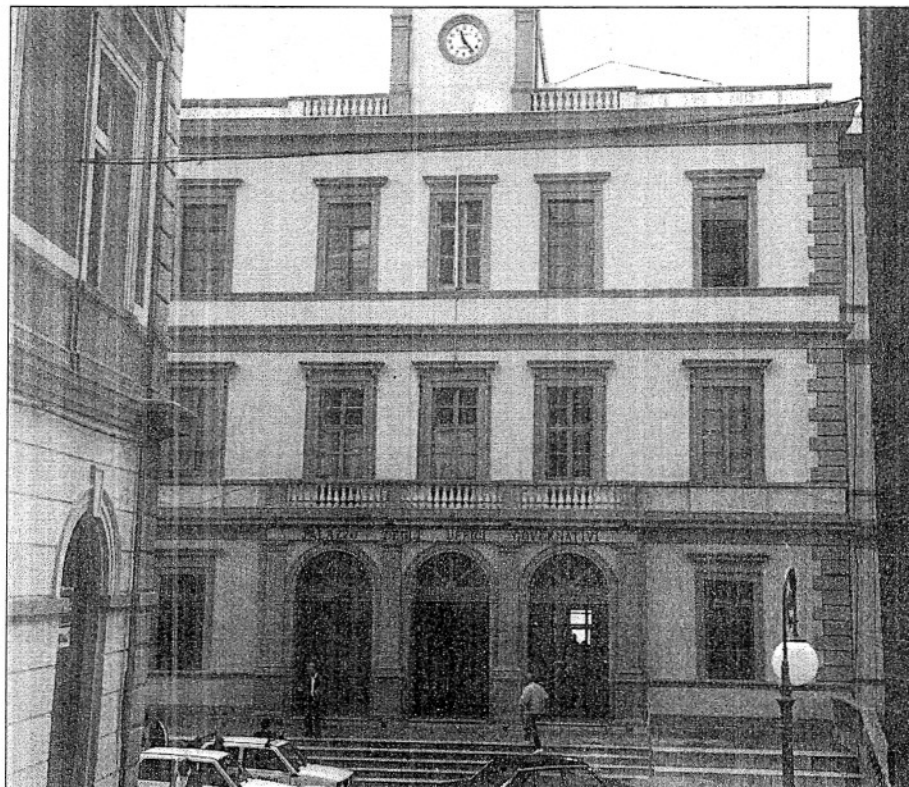
fig. 87 - Potenza, il Palazzo degli Uffici realizzato ma non terminato dall'Architetto G.B. Iazeolla negli ultimi anni della sua vita.
